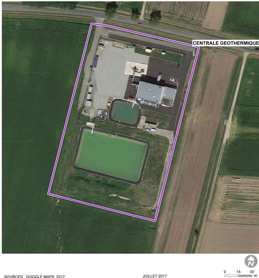
Illustration n° 3 : Vue aérienne de la centrale géothermique de Rittershoffen
